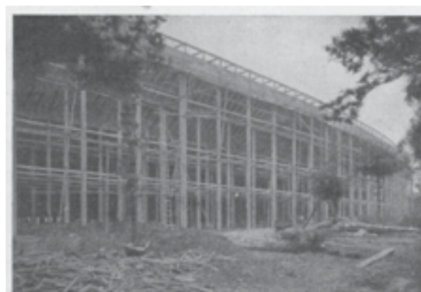
Fig. 7. — Soutènement du virage Est. Les poteaux soutenant le virage Est atteignent 12 mètres de hauteur.
